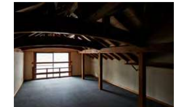
▲屋根裏部屋 和小屋という伝統的な日本建築の工法が用いられている。
